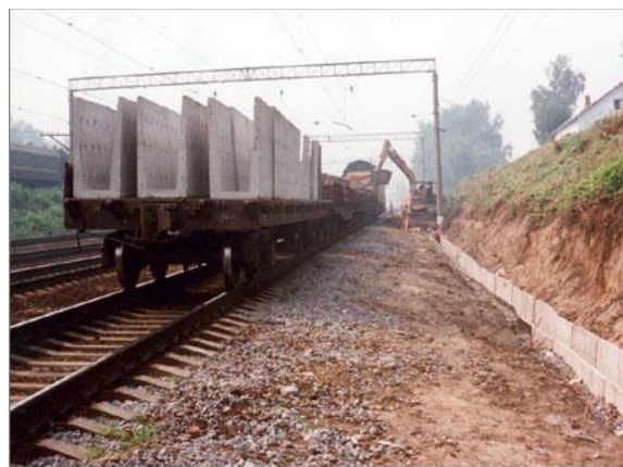
Рис. Установка лотка из железобетона
