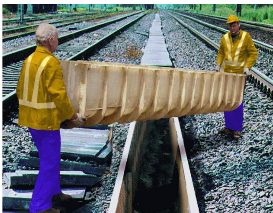
Рис. Установка лотка из ПКМ
