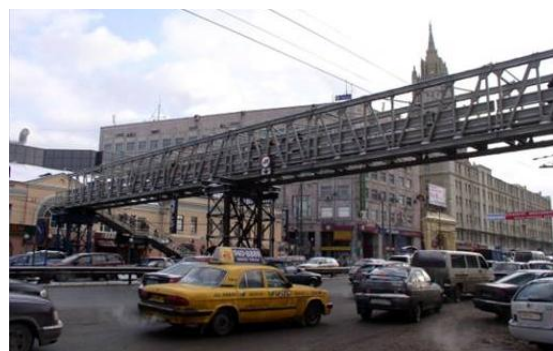
Рис. Композитный мост «АпАТэК» через Смоленскую площадь был установлен за 2 часа без остановки движения транспорта на период ремонта подземного перехода
