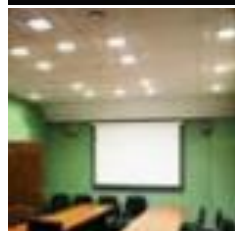
Освещение промышленных и офисных зданий
