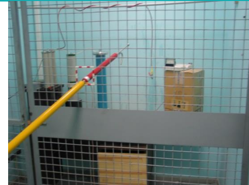
Высоковольтный стенд для испытаний продукции предприятия
