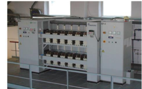
Модуль для производства гипохлорита натрия для систем обеззараживания воды
